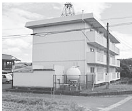
空き室が多くある横田教員住宅
